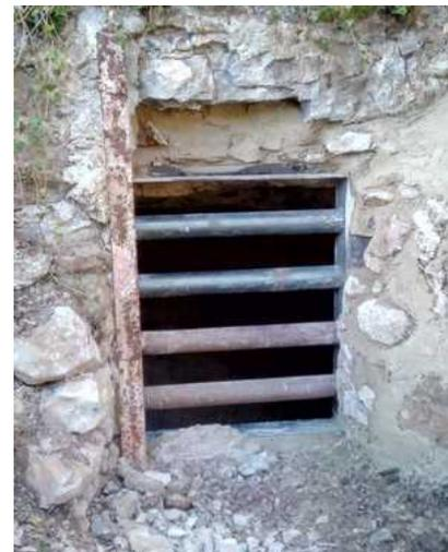
Illustration 3 : Dispositif installé pour le passage des chauves-souris
